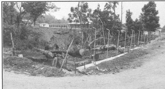
Foto 2: EXCAVACION DE ZANJA PARA LA COLOCACION DE CIMIENTO.
