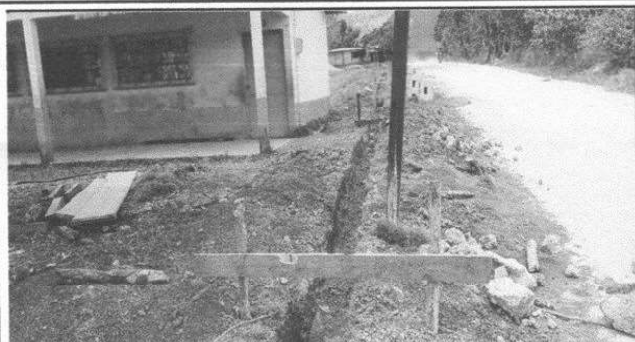
Foto 1: INICIO DEL TRABAJO DE CIRCULACION PERIMETRAL DEL PREDIO DEL ESTABLECIMIENTO.
